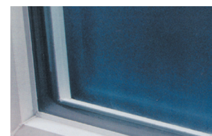
DuraLite Warm Edge Spacer = no condensation
